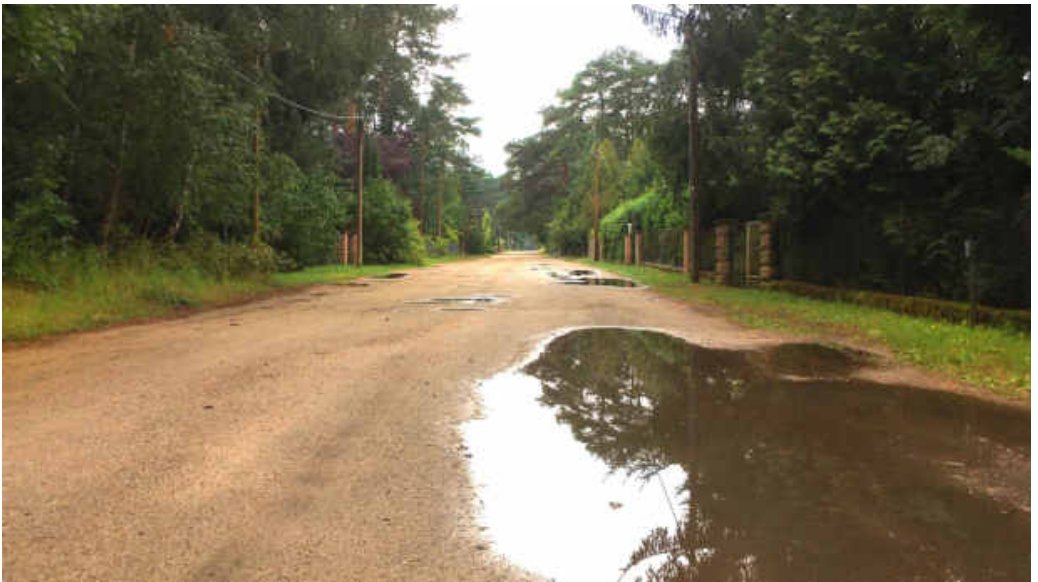
Sandstraße in Borkwalde nach Regen
